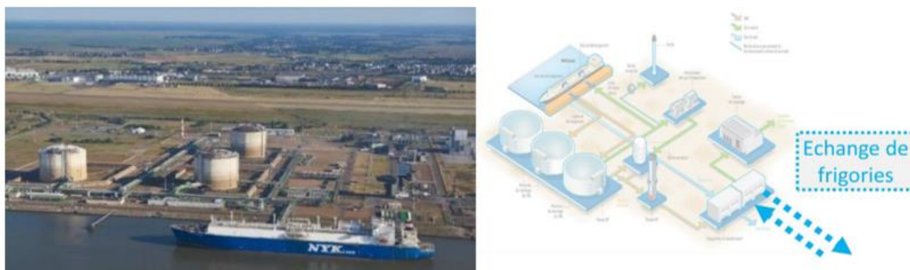
Figure 13 : Illustration de récupération de froid sur le terminal méthanier de Montoir de Bretagne
