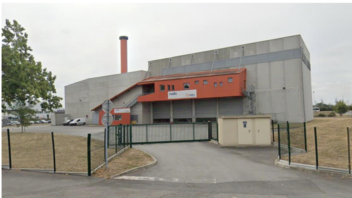
Figure 22 : Illustration d'une chaufferie bois A / gaz (source « Nadic » Nantes Métropole)
