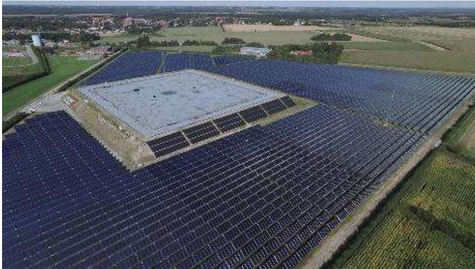
Figure 64 : Installation solaire et stockage inter saisonnier en puits [Source : RAMBOLL, 2017]
