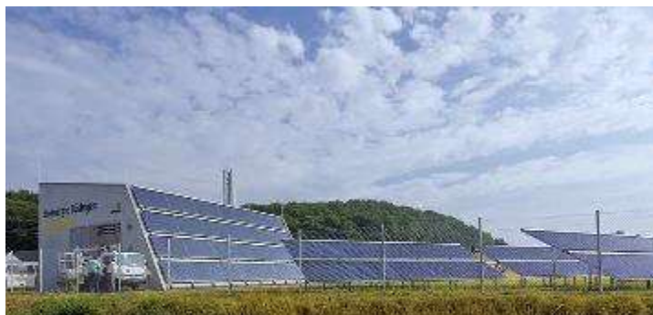
Figure 62 : Centrale de production solaire de Busingen, Allemagne [source : Ritter XL Solar]
