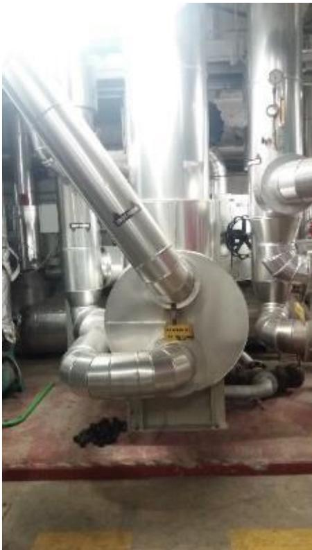
Figure 14 : Echangeur vapeur de 2013. Source : Itherm Conseil.
