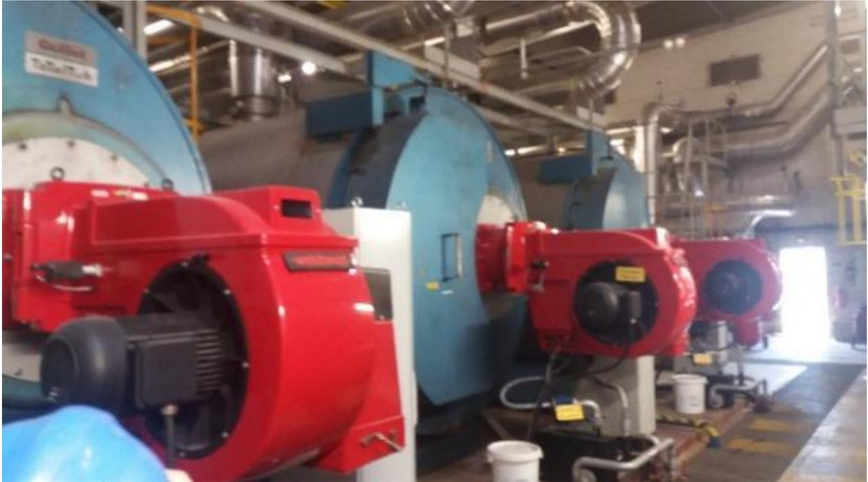
Figure 15 : Chaudières et brûleurs des chaudières de secours. Source : Itherm Conseil.
