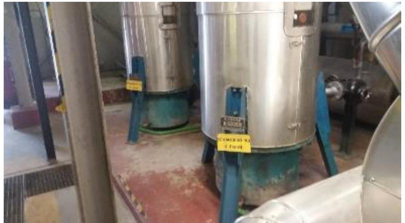
Figure 13. Echangeurs vapeur de 1988 (conservés en secours). Source : Itherm Conseil
