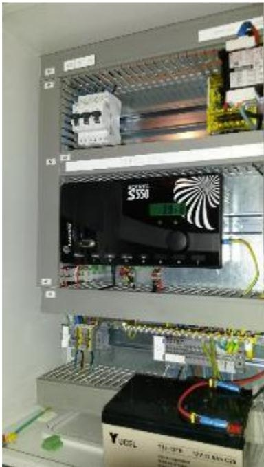
Figure 25 : Automate en sous-station 11. Source : Itherm Conseil.
