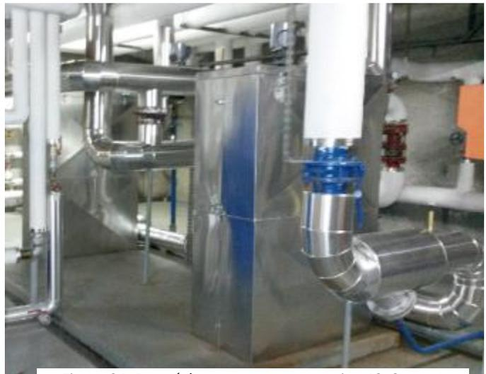
Figure 24. Deux échangeurs en sous-station 12. Source : Itherm Conseil.
