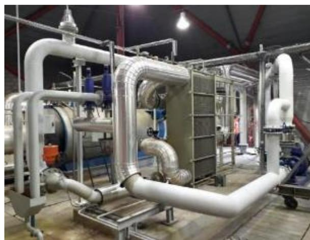
Figure 105 : Echangeur SNECMA - chaufferie d'îlot H - Réseau GPSEP
