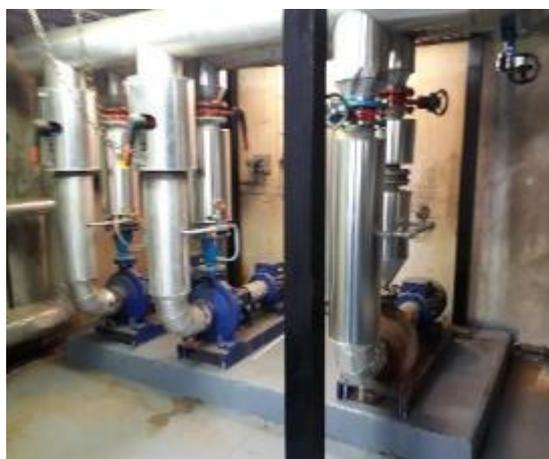
Figure 102 : Pompes réseaux chaufferie d'îlot D - Réseau GPSEP
