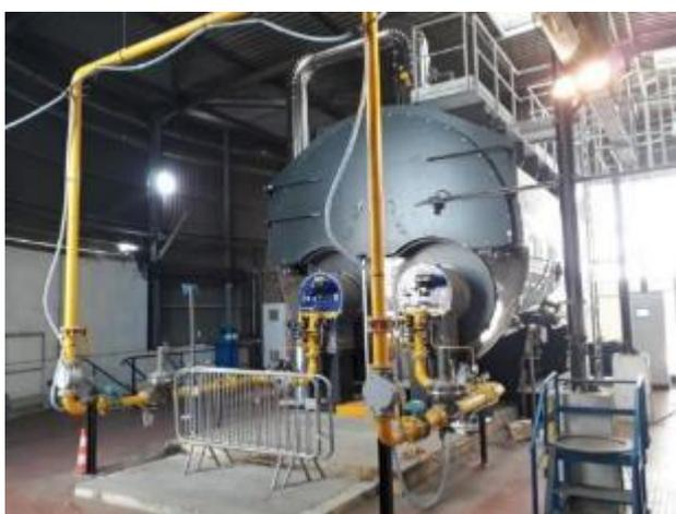
Figure 99 : Chaudière gaz chaufferie centrale et ses deux brûleurs
