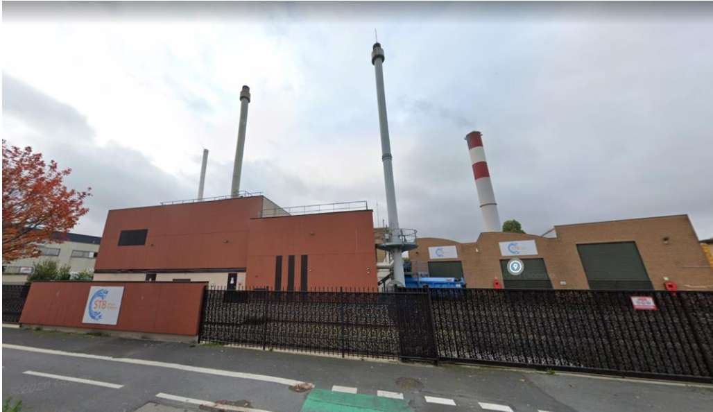
Figure 1 : Vue d'ensemble de la chaufferie principale
