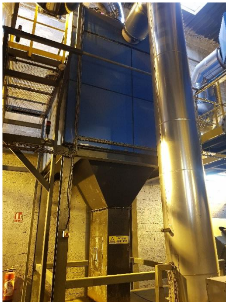
Figure 15 - Filtre à poussière cyclonique
