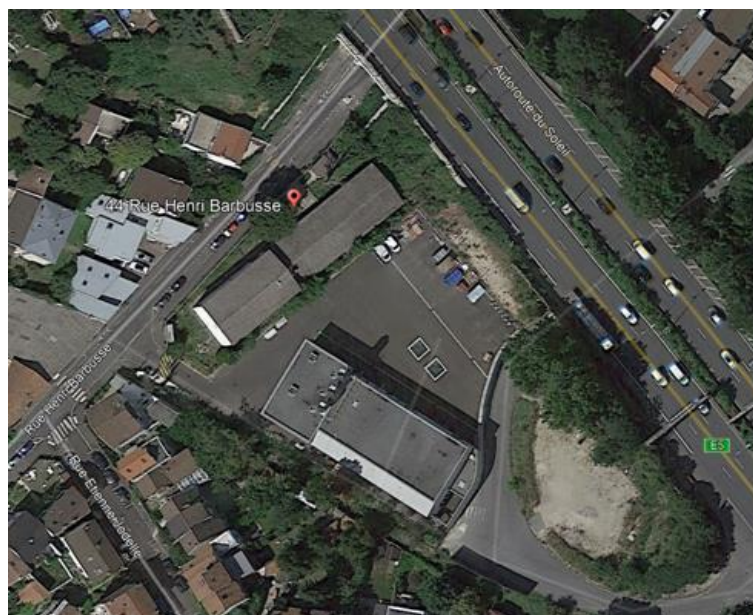
Figure 3 : Vue aérienne de la centrale géothermique
