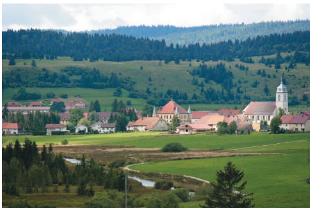
La mairie de Mouthe (25) est alimentée par le réseau de chaleur qui dessert également l'hôpital, le collège... (communauté de communes des Hauts du Doubs).
